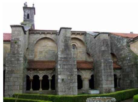
Chama a atención a acusada inclinación dos piare das súas naves, cuxa causa parece indicar a coincidencia de diferentes factores relacionados tanto con algunas deficiencias na construción como coa natureza pantanosa do terreo.
