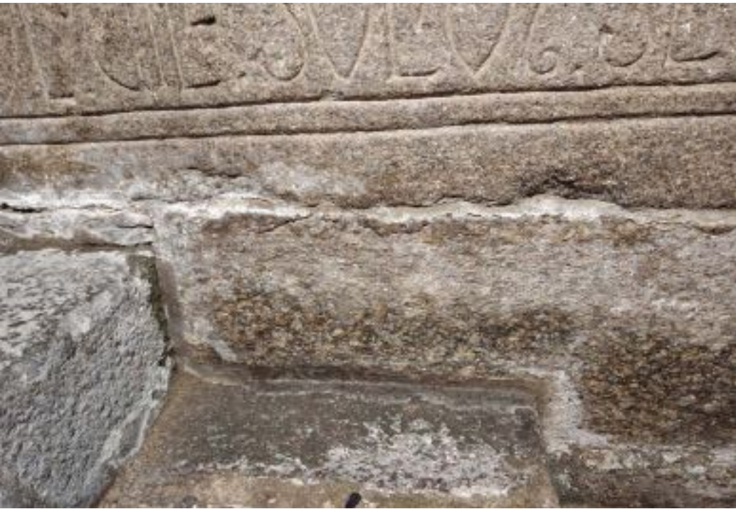
Fig 7 Detalle de degradación en zona de morteiros engadidos.
